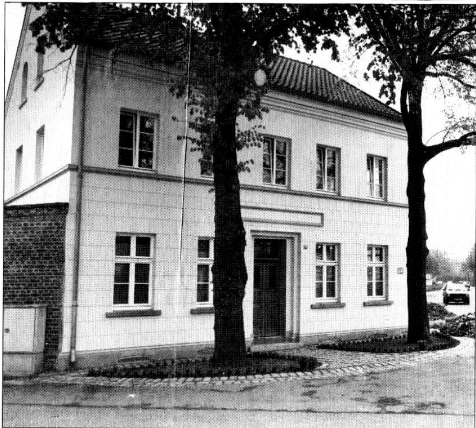
Das Haus Tönisvorster Straße 61 in Süchteln kann sich wieder sehen lassen. Der neue Eigentümer hat es umfassend renoviert. Foto: Franz-Heinrich Busch
