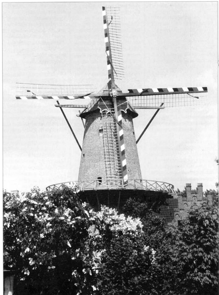
Ein Blickfang weit ins Bergische Land hinein: Die Windmühle am Hanselaerer Tor in Kilar. Bürgervereine nahmen sich des baufälligen Denkmals an. Die restaurierte und wiederbelebte Mühle mit Bierbrauerei, Gaststätte und Backhaus gehört heute zu den Attraktionen der Stadt.
